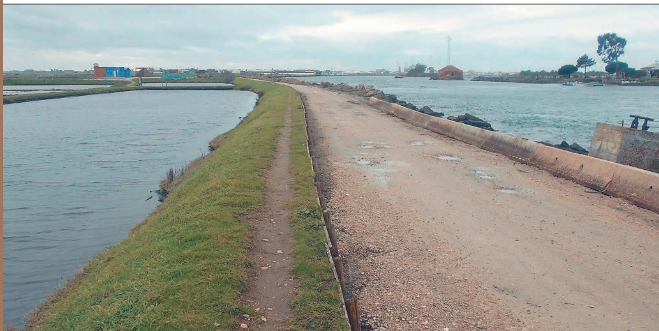
Дамба, ограничивающая со стороны лагуны серию проточных солеродных резервуаров в г.Авейру.
