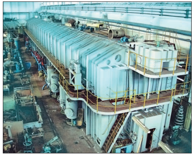
Рис.3. Кавитационный бассейн Крыловского государственного научного центра. Хорошо видна внешняя герметичная оболочка бассейна, внутри которой можно создавать разрежение воздуха и за счет этого менять числа кавитации исследуемых объектов.
